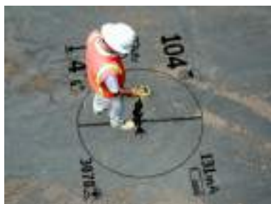
Рис. 2. Фиксация планового положения труб и измерения глубины;
